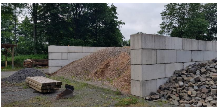
Das 100 Quadratmeter große Trocknungslager hat eine Betonsteineinfassung in der die Holzhackschnitzel als Schüttgut getrocknet werden
